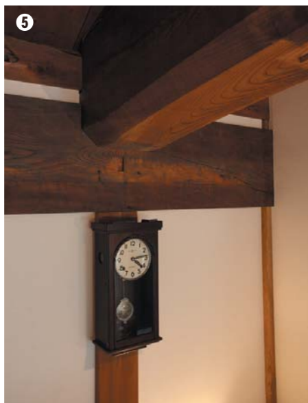
③フラットな壁、天井と、蔵の面影を残す1階の空間。天井は、既存より25cmほど高くした。床は無垢のチークに塗装し、奥様の希望である華やかな色みのフロアが実現。④吹き抜けとなった玄関。⑤奥様が惹かれた見事な梁組みを再現。200年の時を経た貫禄がある。⑥既存の箱階段も再利用。
