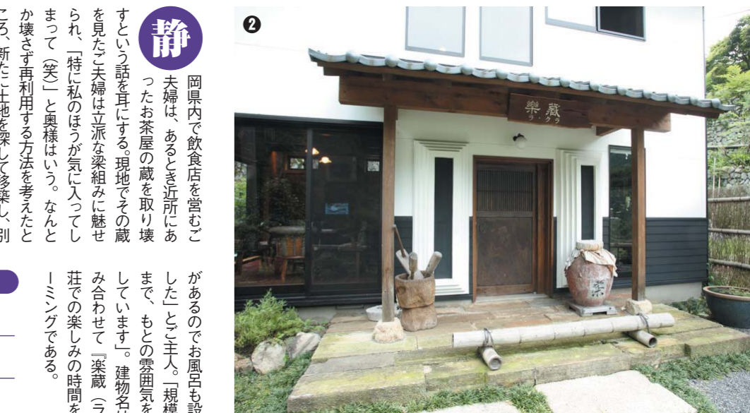
①「楽蔵」は山間を見下ろす絶好のロケーションにある。茶葉を保管しておくための蔵であったもとの建物の雰囲気はそのまま残したが、開口部を追加するなどして利便性を高めている。②既存蔵戸を再利用した玄関。もともと古材が好きだったご夫婦は、シティアートが運営する古材ショップ&ショールーム「ぎやらりい門」にたびたび訪れていたのだとか。
